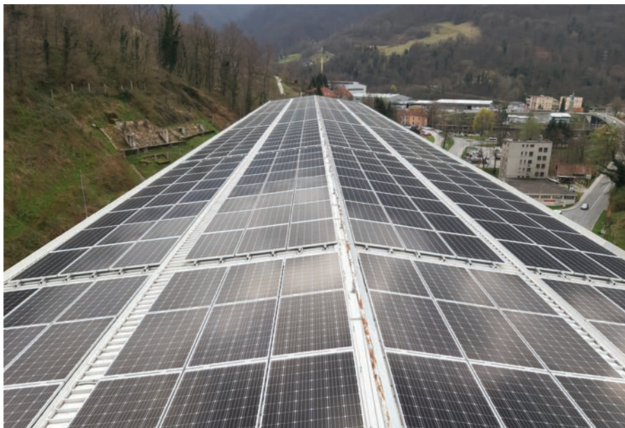
Na strehi Steklarne Hrastnik je podjetje GEN-I predlanskim zgradilo sončno elektrarno z vršno močjo 184,2 kilovata in načrtovano proizvodnjo 157 megavatih ur električne energije. Z elektrarno zmanjšajo izpuste ogljikovega dioksida za približno 80 ton na leto. Foto: Borut Hočevar
